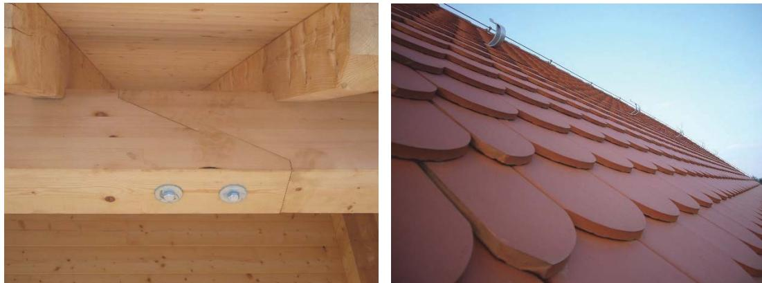
最後に見学したプレカット工場の近くのブロックハウス(角ログハウス)の建設現場です。住宅ではなくボイースカウトの施設のため少々大きいですが、 $240 \times 240$  mmの集成角材をログハウスとして積上げたもので、主要な梁桁以外の床梁や造作、仕上はムク材でした(接合部は金物)。建具や水切りも全て木で、屋根は素地の瓦のようなものが葺かれています。
