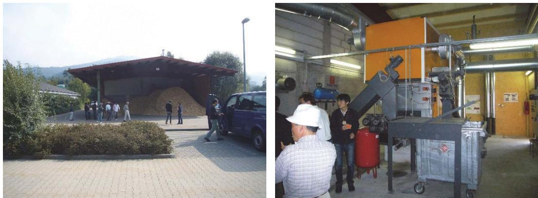
1996年に製材工場として建設、同時にその端材で熱供給事業も開始(住宅地開発においてはこのような熱供給が義務付けられています)しましたが、1999年に倒産。その後新組織により熱供給事業のみ再開している施設です。付近の75世帯の住宅と2つのスーパー、自動車代理店、隣接工場の熱供給を行っていて、年間120万Kwの熱供給をしています。チップの自動投入により燃焼+灰の2次燃焼でチップを乾燥しながら湯をつくり、熱交換器により高圧の湯へ熱を移し、輸送パイプで各家庭に暖房や給湯用の熱エネルギーとして供給されています。輸送パイプの事故はセンサーで管理し、万一の場合に備えて石油ボイラーも併設されています。施設の管理は別の場所の事務所で、遠隔操作(24時間体制)にて行われています。
