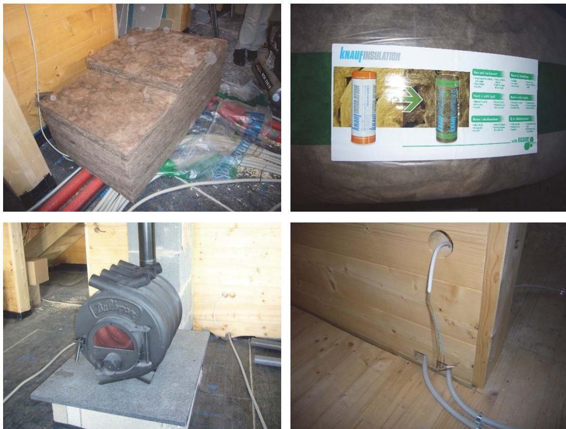
この施設の木材の使用量は  $150\text{m}^3$  だそうです。一般的な住宅でも  $70\text{m}^3/\text{件}$  は使うとのことで、炭素固定量も膨大です。断熱材(床と屋根?)にはエコ化された繊維系のものが使用され、主暖房は薪ストーブです。電気コンセントも全て電磁波対応のアース付きでした。
