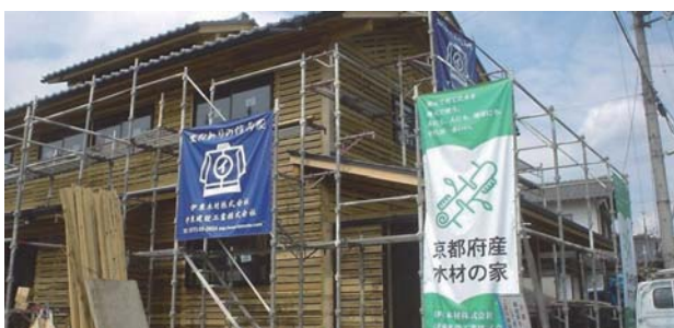
(住宅建設現場：のぼり等による制度のPR)
